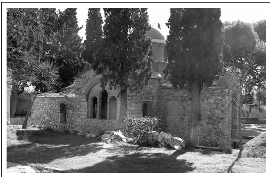
Όψη Βόρεια. Φωτο: Ι. Γουλής, 2004.
