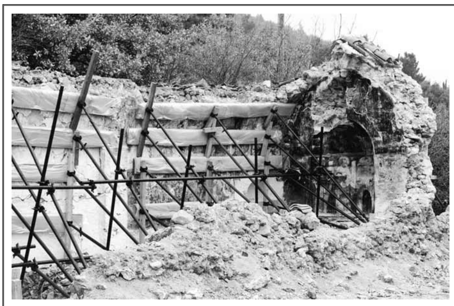
Αγ. Νικόλαος «Μετόχι». Εσωτερική υποστήλωση βόρειας πλευράς. Φωτο: Δ. Γ., 2004.
